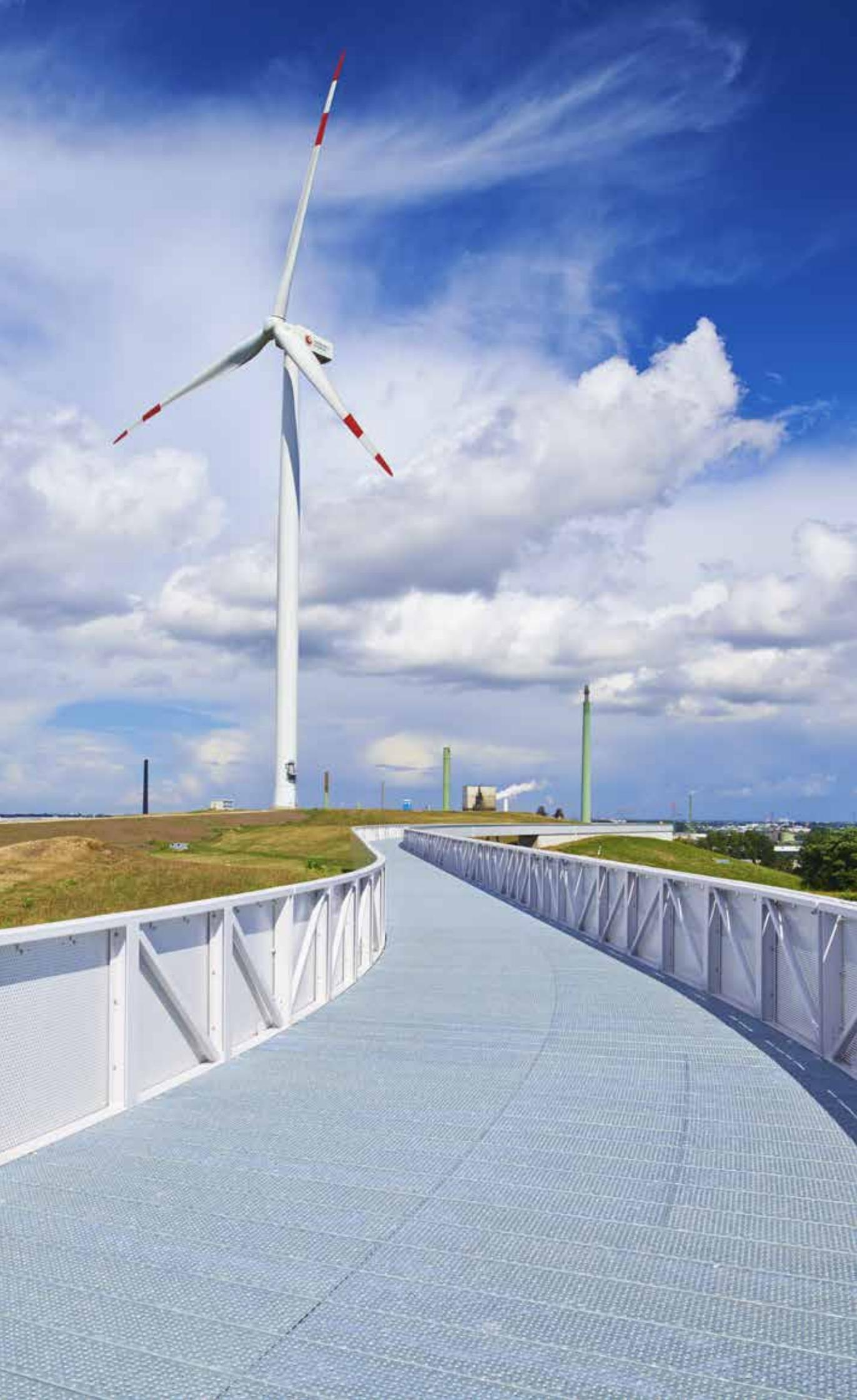
O uso de superfícies antiderrapantes é necessário em várias áreas, a fim de garantir a segurança e a estabilidade ao caminhar. As diferentes estruturas de superfície dos pisos perfurados e recalçados MEISER possibilitam um amplo espectro de aplicações. Ao mesmo tempo, os pisos perfurados e recalçados tem grande apelo estético e são utilizados, tanto pelo usuário industrial quanto por arquitetos, como revestimento de fachadas ou como parasol.
