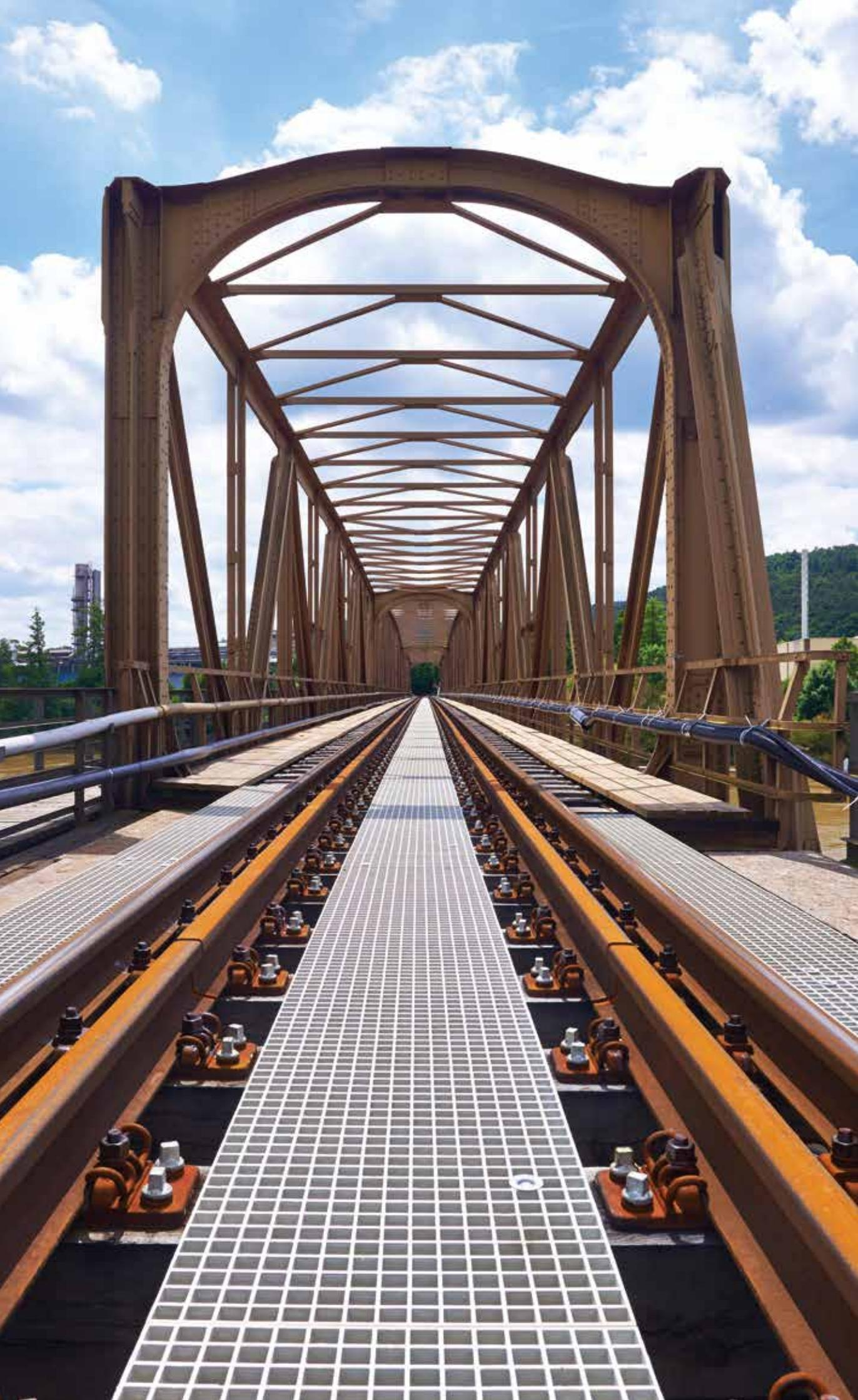
O sistema de pisos PRFV (poliéster sintético reforçado com fibra de vidro) foi especialmente desenvolvido para áreas industriais e públicas nas quais a resistência à corrosão seja extremamente importante. É de fácil e rápida instalação, tem alta capacidade de carga e proporciona maior conforto e segurança.
